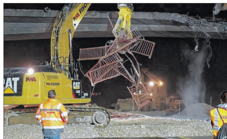
Einer hat das Geländer in der Zange, der andere meißelt am Beton. Für die Abbrucharbeiten wurde die A 8 zu ihrem Schutz mit einem Fallbett aus Schotter belegt.
