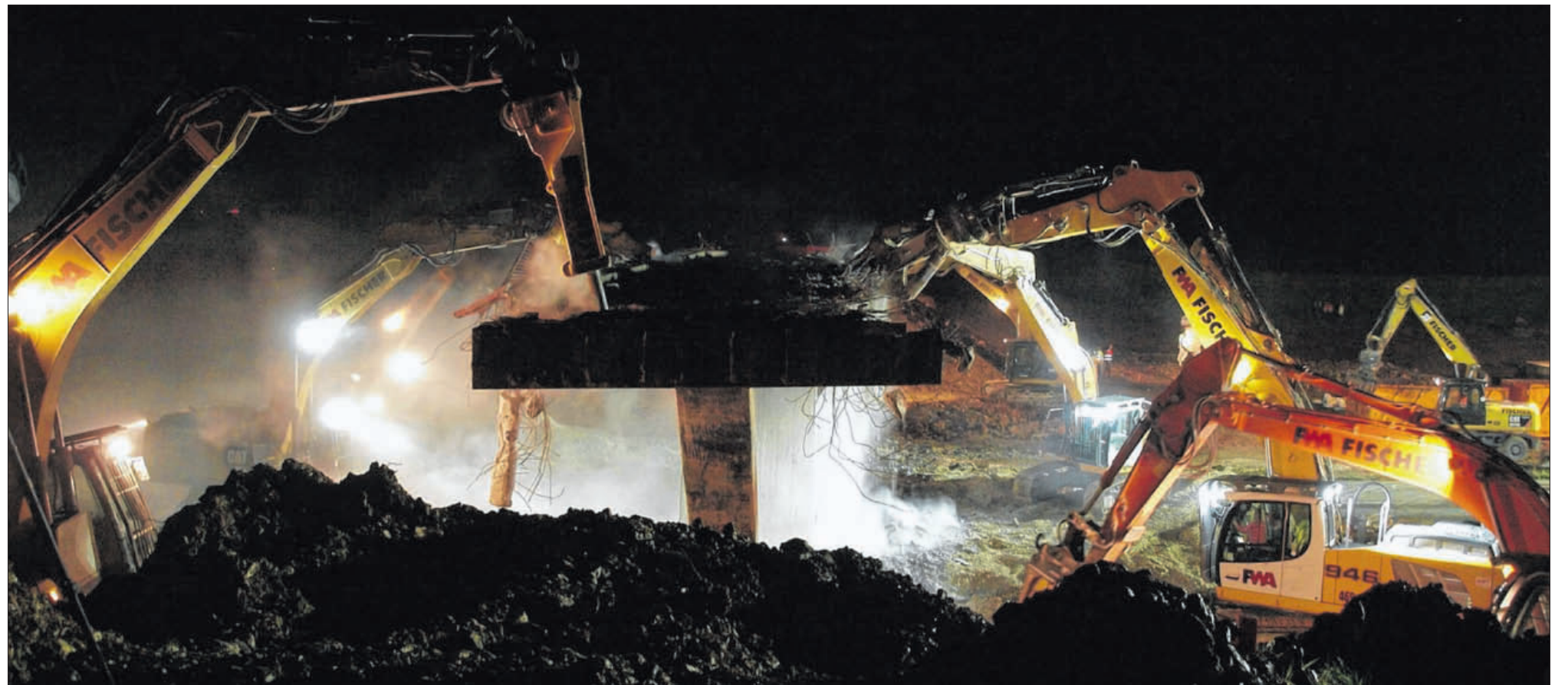
Große Bagger, ausgerüstet mit Meißel, Schere und Zange, machten sich über die Stahlbetonbrücke her. Die gut vorbereitete Aktion lief wie am Schnürchen.
