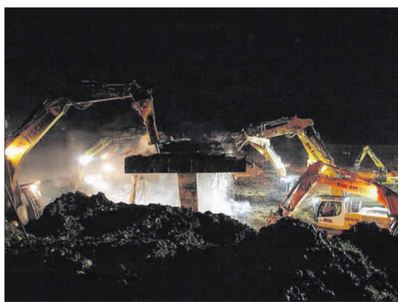
Große Bagger, ausgerüstet mit Meißel, Schere und Zange, machten sich über die Stahlbetonbrücke her. Die Aktion lief wie am Schnürchen. Foto: Joachim Striebel
